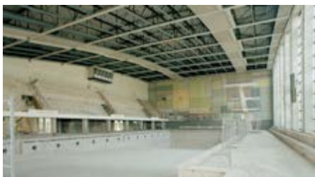
Das Schwimmbad während der Sanierungsphase.
