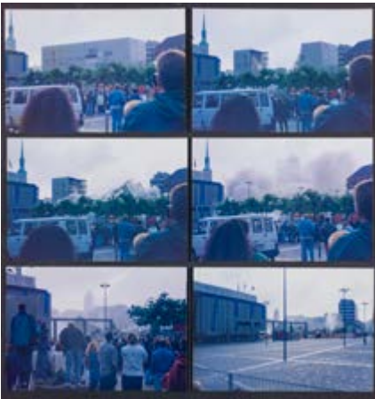
Sprengung des Hauses der Bibliotheken am 23.06.1996, Fotoserie.
