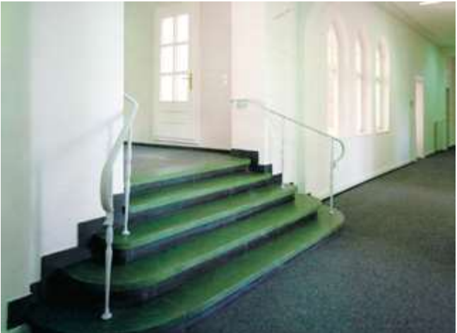
Das Wohlfahrtsgebäude in Eving, in dem sich früher u. a. Kindergarten, Hauswirtschafts- und Kochschule, Wäscherei, Bibliothek und eine Badeanstalt befanden, nach der Restaurierung 1992.
