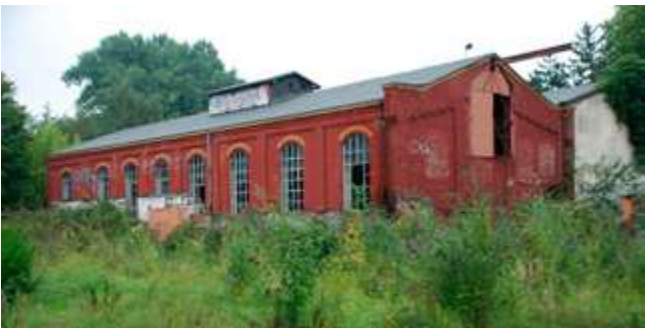
Die beiden Hallen, in denen bis 1963 die Verwaltung und die Kauen der Zeche Dorstfeld I/III untergebracht waren, standen viele Jahre lang leer.
