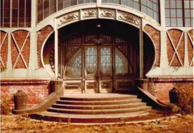
Zählte bis Ende der 1960er-Jahre zu den wenig geschätzten Industrieanlagen: die Zeche Zollern II/IV, hier das Portal der Maschinenhalle 1970.
