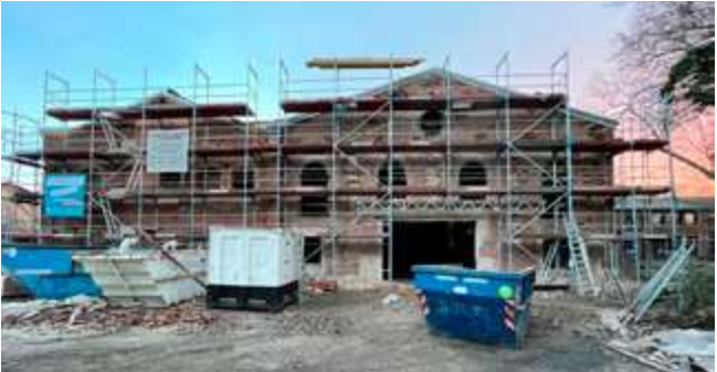
Die seit 1987 unter Denkmalschutz stehenden Gebäude wurden zwischen 2018 und 2022 zu einem Bürgerhaus umgebaut.
