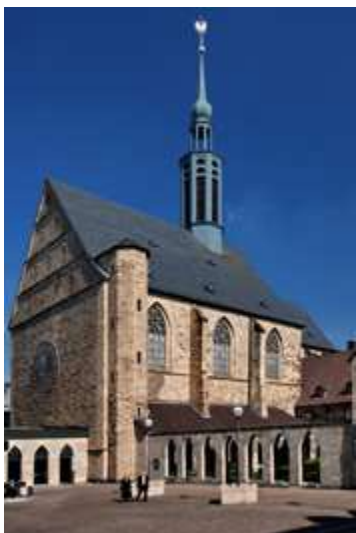
Blick auf die Probsteikirche mit modernen „Zutaten“ in Sandstein.
